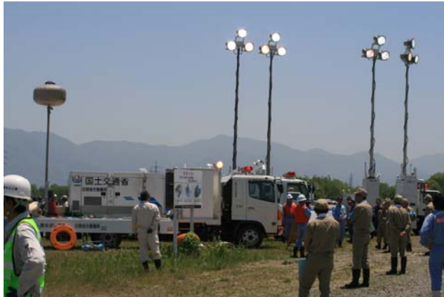
排水ポンプ車 排水作業展示
