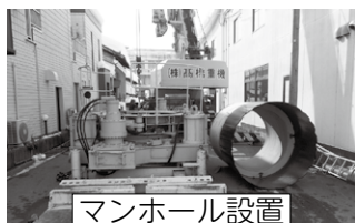
マンホール設置
