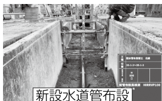
新設水道管布設
