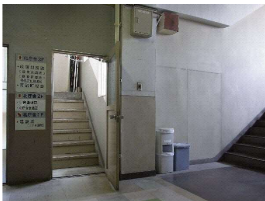
本庁舎と北庁舎の接続部
