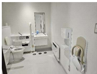
多目的トイレ (双葉町役場)
