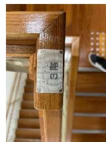
階段手すり点字 (南会津町役場)
