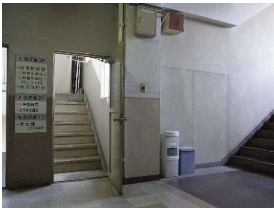
本庁舎と北庁舎の接続部
