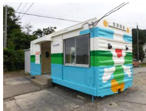
図 2 8 会津坂本駅舎整備 (令和 4 (2022) 年度 施工)
