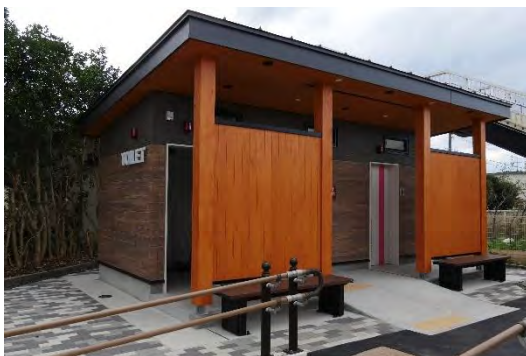
図 2 7 会津坂下駅前公衆トイレ整備 (令和 3 (2021) 年度 施工)
