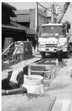
下水道整備工事
