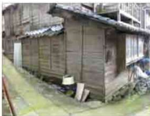
外壁が裸木造の例
