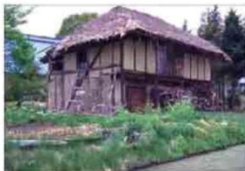
屋根材がワラの例
