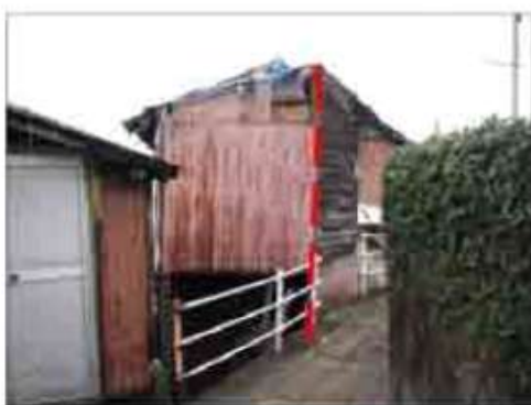
一部の柱が傾斜している例
