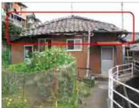
屋根に不陸がある例
