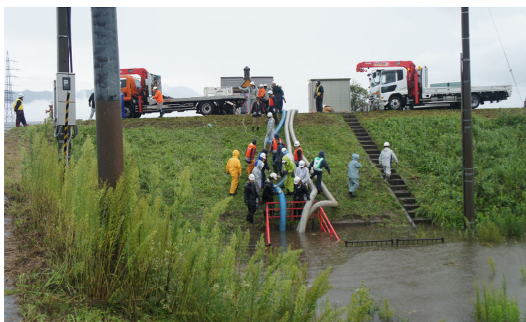
平成 27 年 9 月 10 日 広瀬地区五香地内 (五香排水樋管) 排水作業
