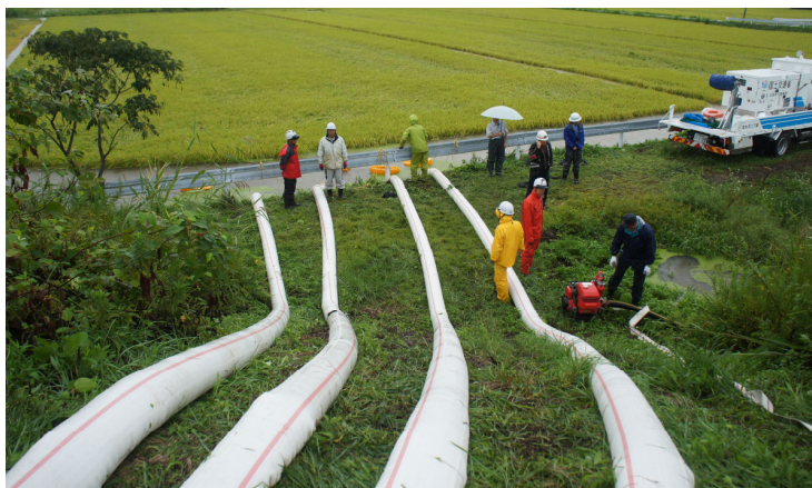
平成 27 年 9 月 10 日 金上地区細工名地内 (細工名 2 号樋門) 排水作業
