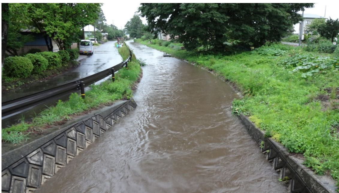
栗村水路（原地内）
